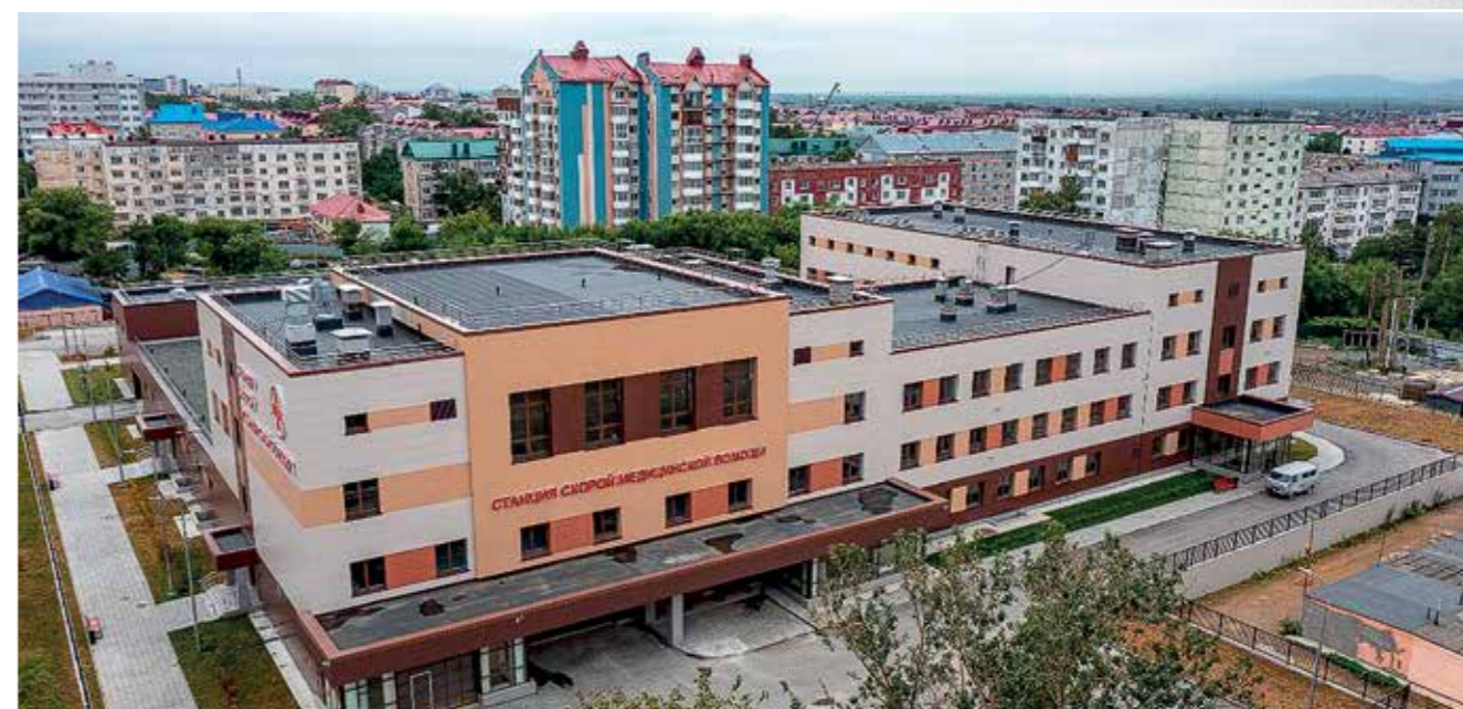
Новое здание станции скорой помощи. 2021 г.
