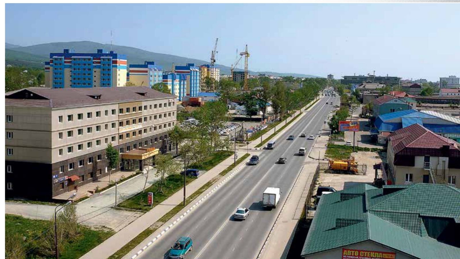
Участок проспекта Мира после реконструкции. Слева – строительство нового микрорайона Эдем. 2011 г.
