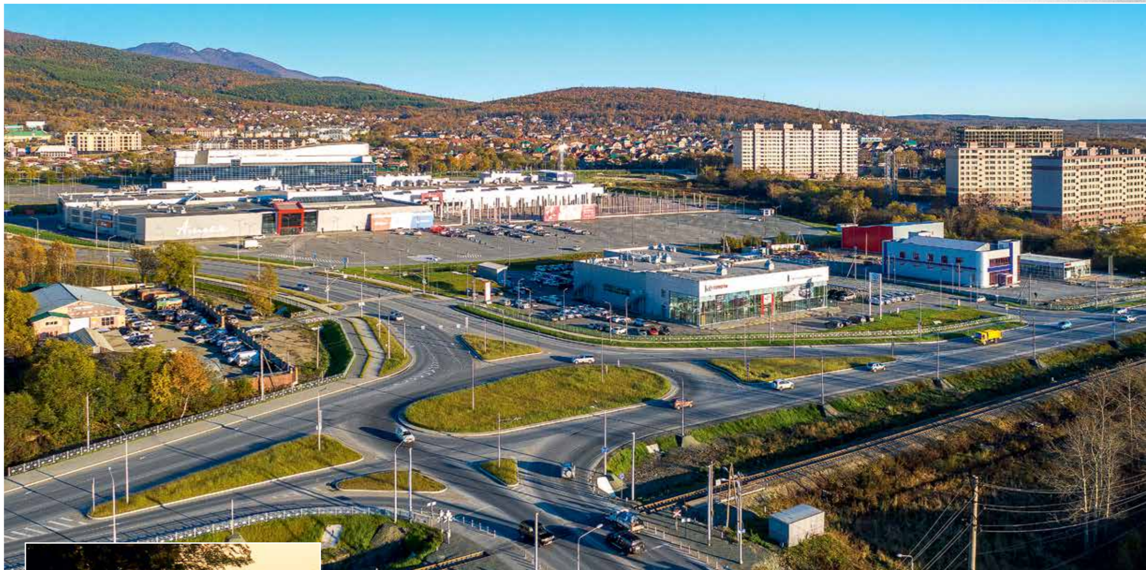
Участок дороги на перекрестке улиц Ленина и И.П. Фархутдинова после реконструкции. 2020 г.
